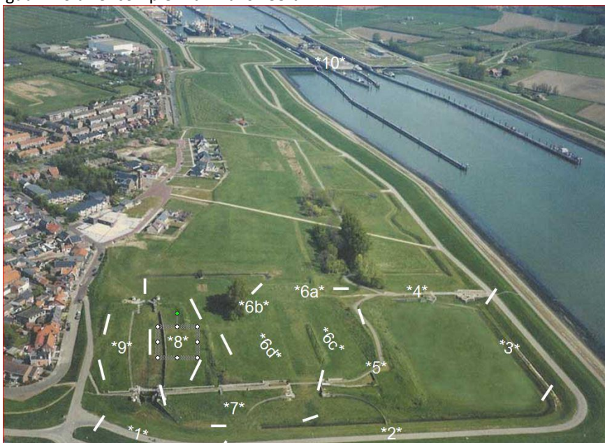
Figuur 1: Sluiscomplex van Hansweert.
